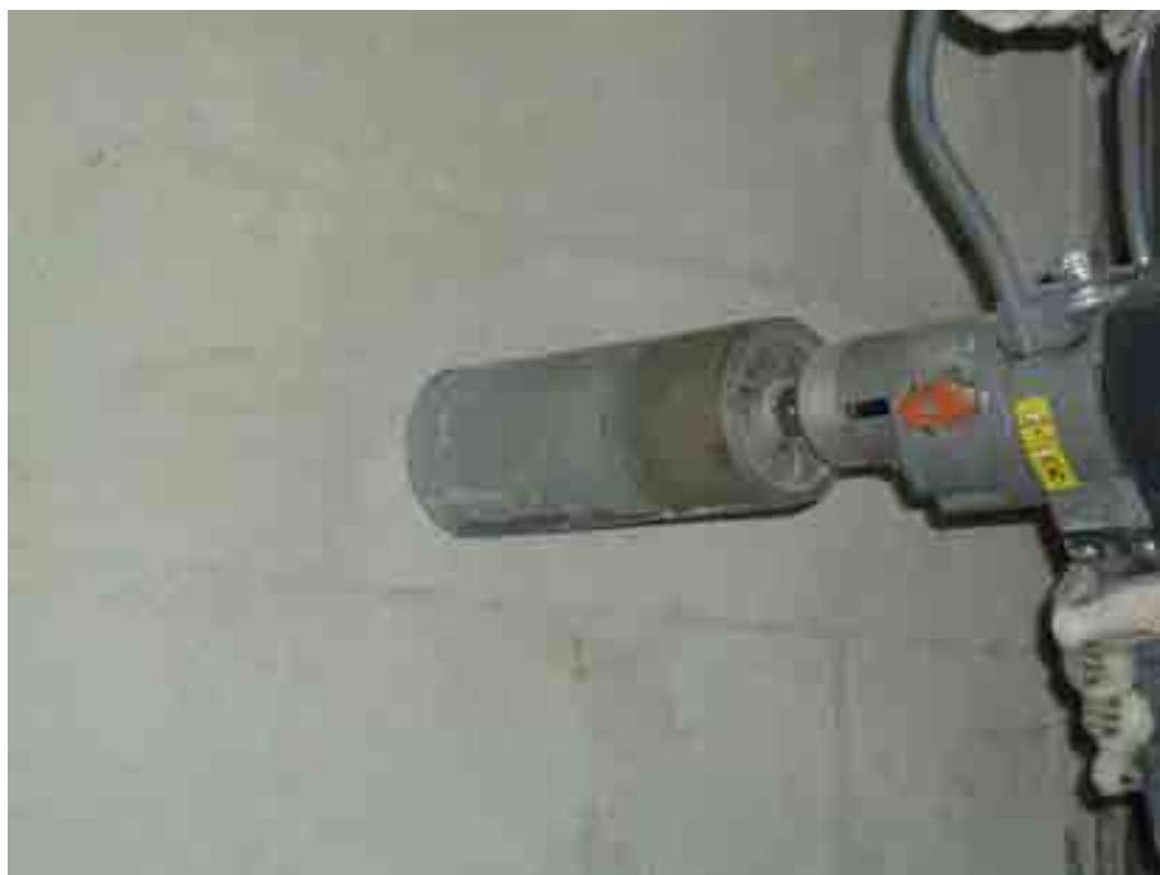
Рисунок 2.1 – Висвердлювання керна
