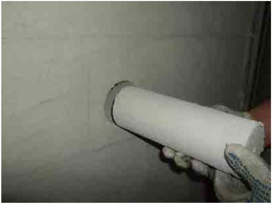
Рисунок 2.2 – Відбір зразка газобетону з фрагменту огорожувальної конструкції
