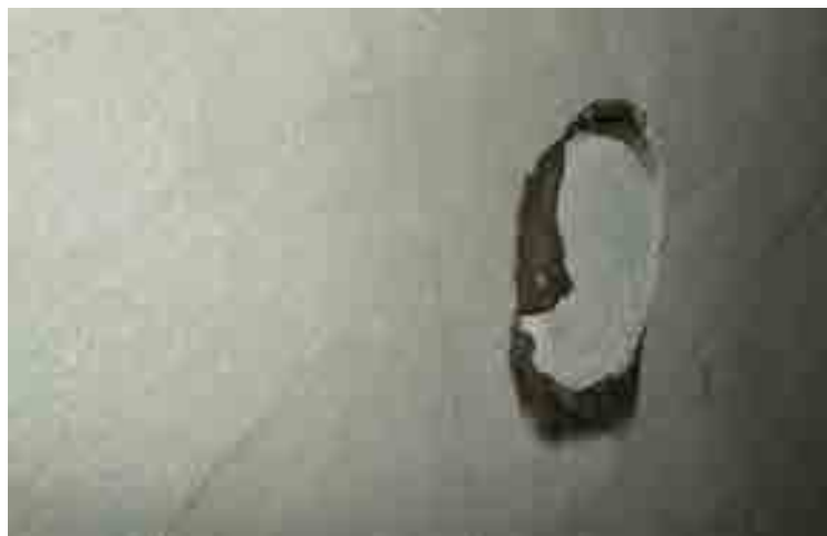
Рисунок 2.5 – Отвір, що утворився після відбору зразка, закладено керном з газобетону
