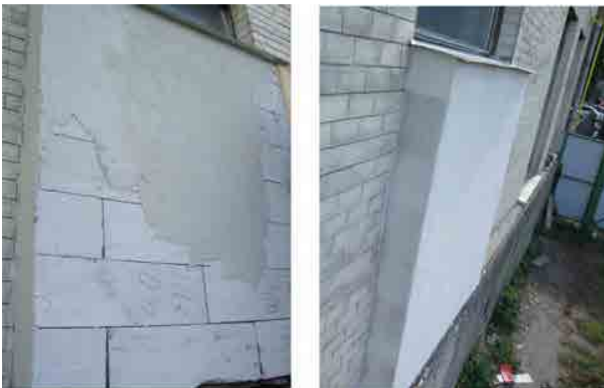
Рисунок 1.14 – Дослідні фрагменти огорожувальних конструкцій з автоклавного ніздрюватого бетону відразу після укладання блоків (а) та після влаштування штукатурного шару (б)
