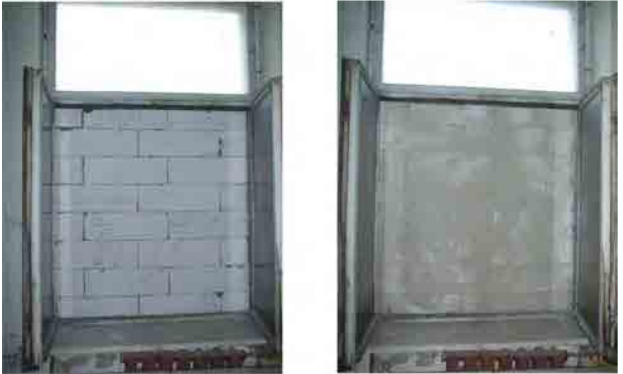
Рисунок 1.15 – Зовнішній вигляд фрагментів огорожувальних конструкцій з автоклавного бетону зі сторони лабораторного приміщення
