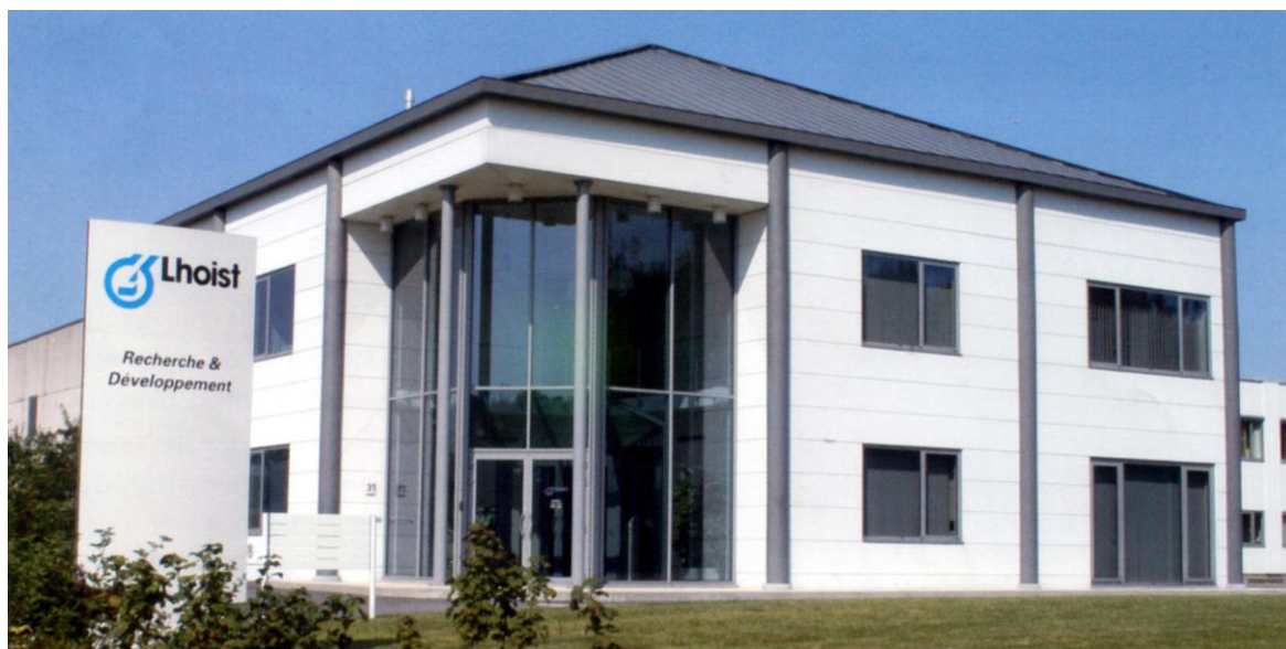
Рис. 4. Здание офиса со стенами из газобетонных панелей
