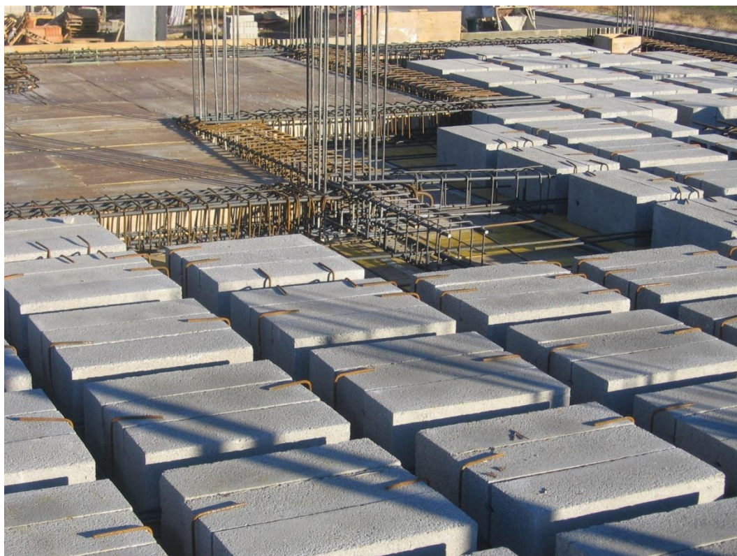
Рис. 15. Кессонно-блочные сборно-монолитные перекрытия МАРКО-КЕССОН с газобетонными блоками
