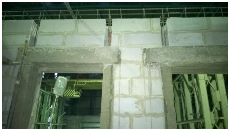
Рис. 2. Изготовление железобетонных включений
