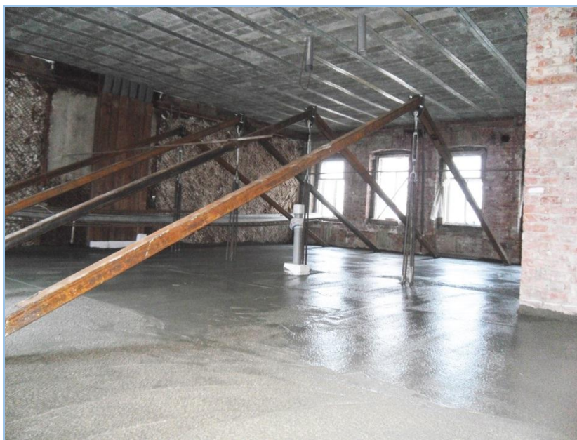
Рис. 10. Замена деревянных перекрытий в квартире на Малой Бронной. Длина профильных балок 12 м
