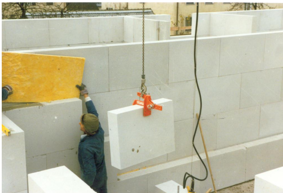
Рис. 2. Монтаж крупных блоков
