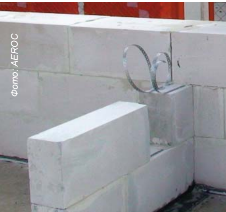
Плоские анкеры позволяют выполнять сопряжение стен без перевязки
