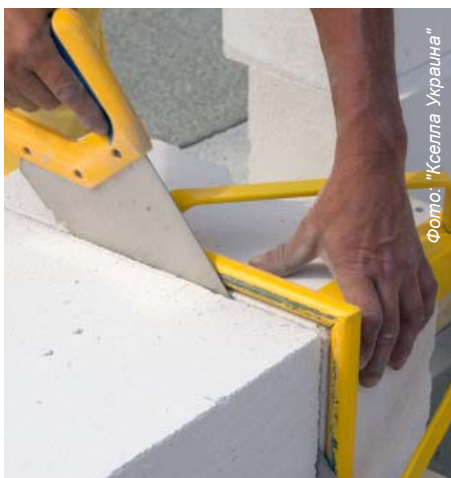
Газобетон легко обрабатывается — его можно резать простой пилой
