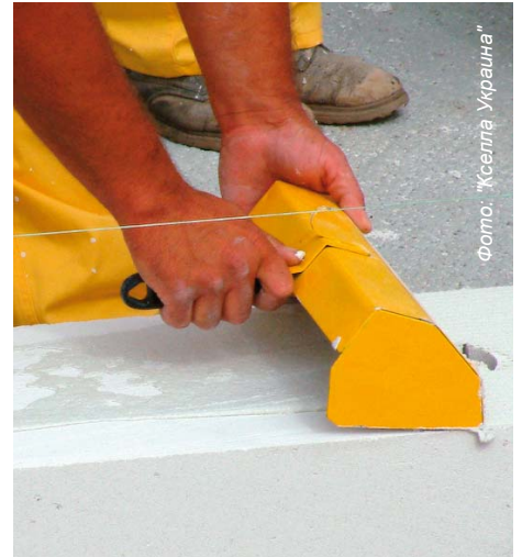
Специальный ковш позволяет наносить клеевой раствор тонким слоем по всей ширине блока
