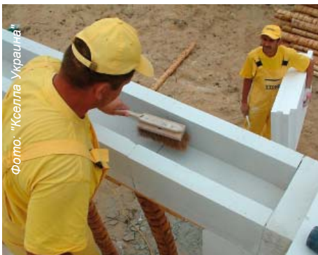
Для выполнения перемычек используют U-образные блоки
