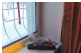
Теплопотери вызваны дефектом установки окна. Недостаточная герметизация
