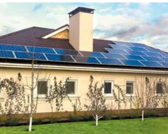
Фотоэлектрическая система под «Зеленый тариф»
