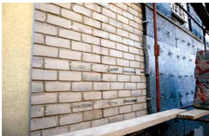
Монтаж вентилируемого фасада
