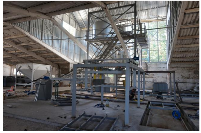
Рис. 2. Монтаж оборудования линии AER-100: а) - общий вид монтируемой линии со стороны склада сырьевых материалов; б) - вид линии от шлам-бассейнов; в) – портал съема бортов и линия резки; г) – смесительная этажерка
