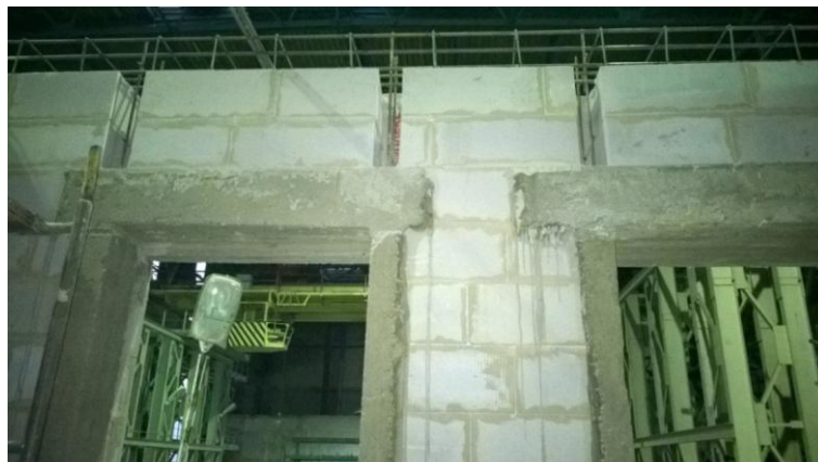
Рис. 2. Изготовление железобетонных включений
