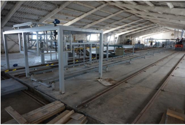
Рис. 2. Монтаж оборудования линии AER-100: а) - общий вид монтируемой линии со стороны склада сырьевых материалов; б) - вид линии от шлам-бассейнов; в) – портал съема бортов и линия резки; г) – смесительная этажерка
