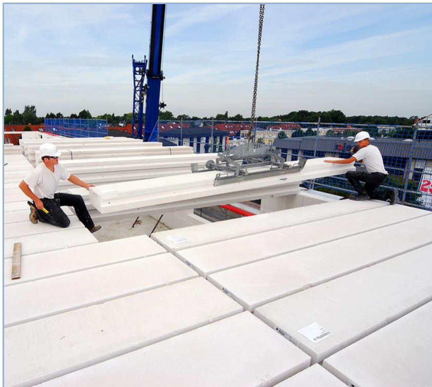
Рис. 1. Монтаж плит перекрытия из газобетона
