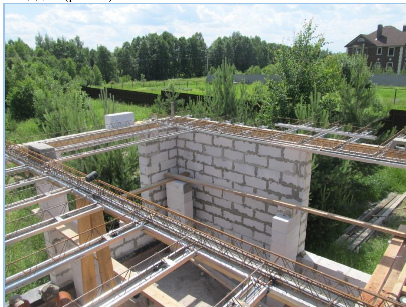
Рис. 9. Проем под «второй свет» в перекрытии организован за счет стыковки балок ПРОФИЛЬ под прямым углом
