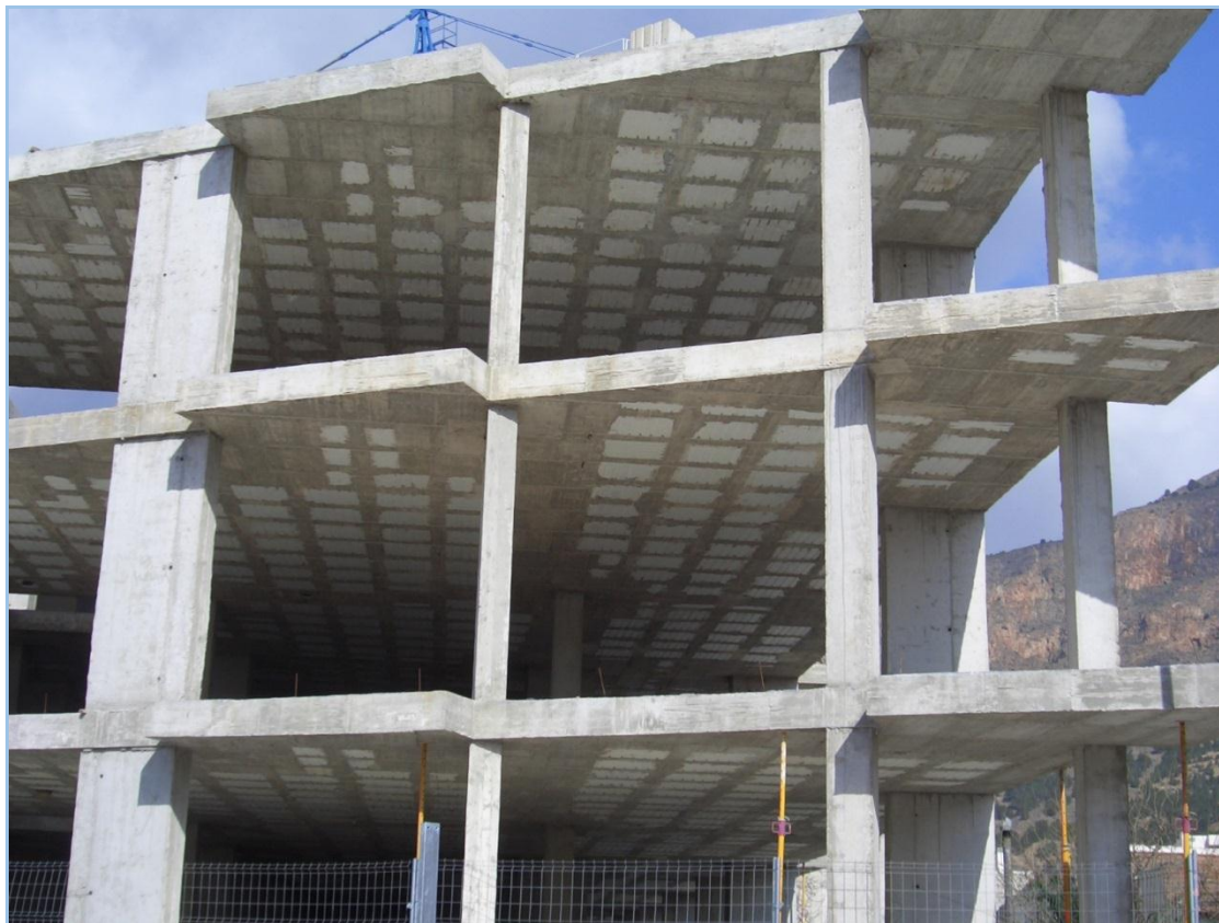
Рис. 16. Газобетонные блоки в конструкции перекрытий каркасно-монолитного дома
