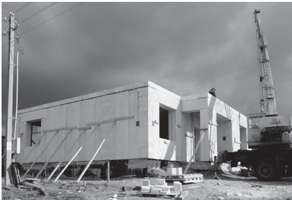
Рис. 11. Монтаж полносборного дома из армированных ячеистобетонных изделий внизу – монтаж панели вилочной траверсой; сверху – общий вид смонтированной “коробки” дома
