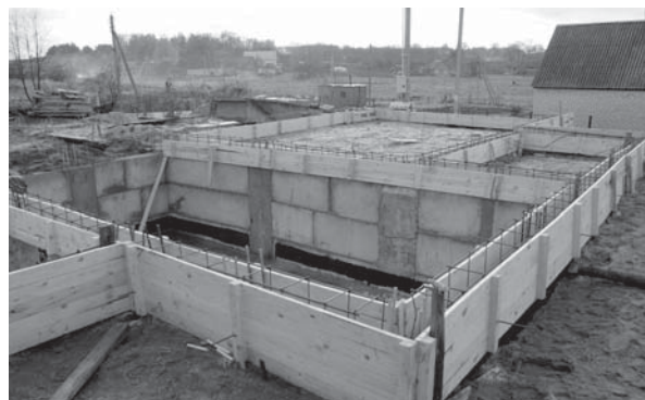
Рис. 10. Фундамент экспериментального жилого дома в процессе строительства: вверху – общий вид; внизу – фрагмент (с засыпанными пазухами) со стороны технического подполья
