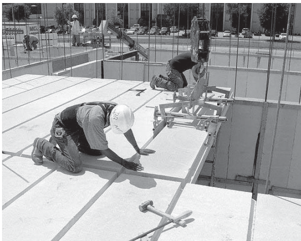
Рис. 5. Строительство полносборных зданий из армированных ячеистобетонных изделий производства компании NEBEL (США); слева – монтаж плит перекрытия на стены из вертикальных несущих панелей; справа – пятиэтажное здание гостиницы
