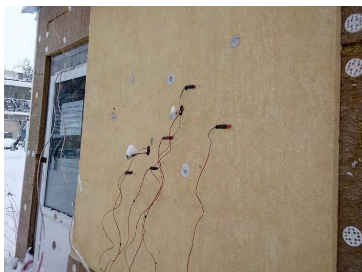
Рисунок 8 – Приклад розміщення датчиків теплового потоку та температури для випробування опору теплопередачі огорожувальних конструкцій будинку
