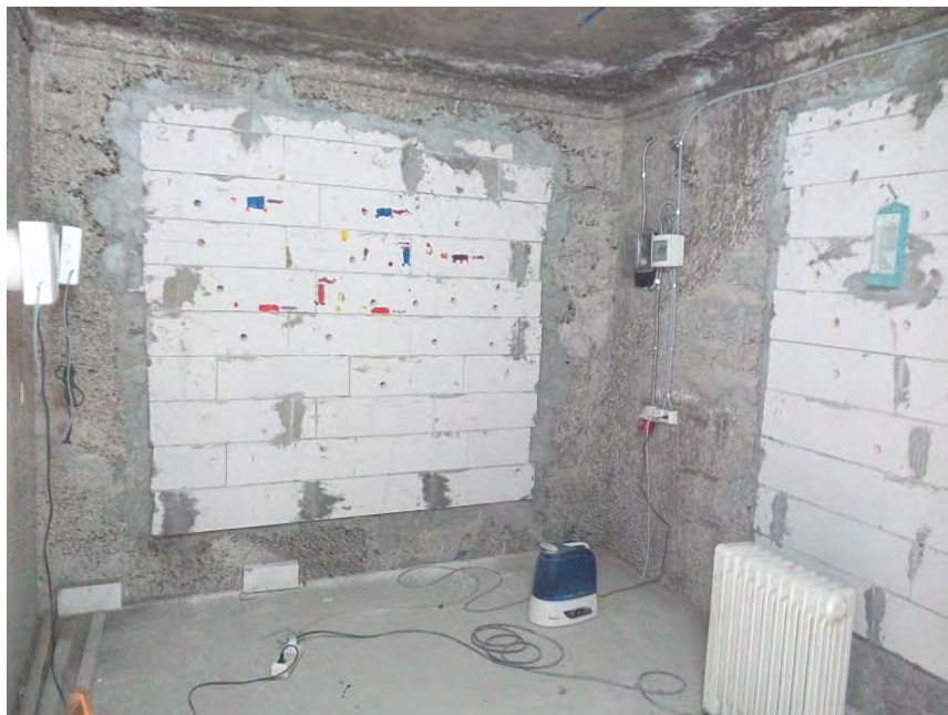
Рисунок 3 – Зовнішній вигляд заповнення газобетоном отворів в керамзитобетоні
