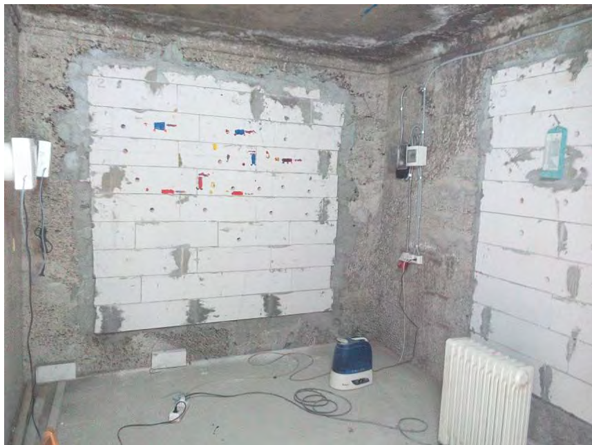
Рисунок 3 – Зовнішній вигляд заповнення газобетоном отворів в керамзитобетоні
