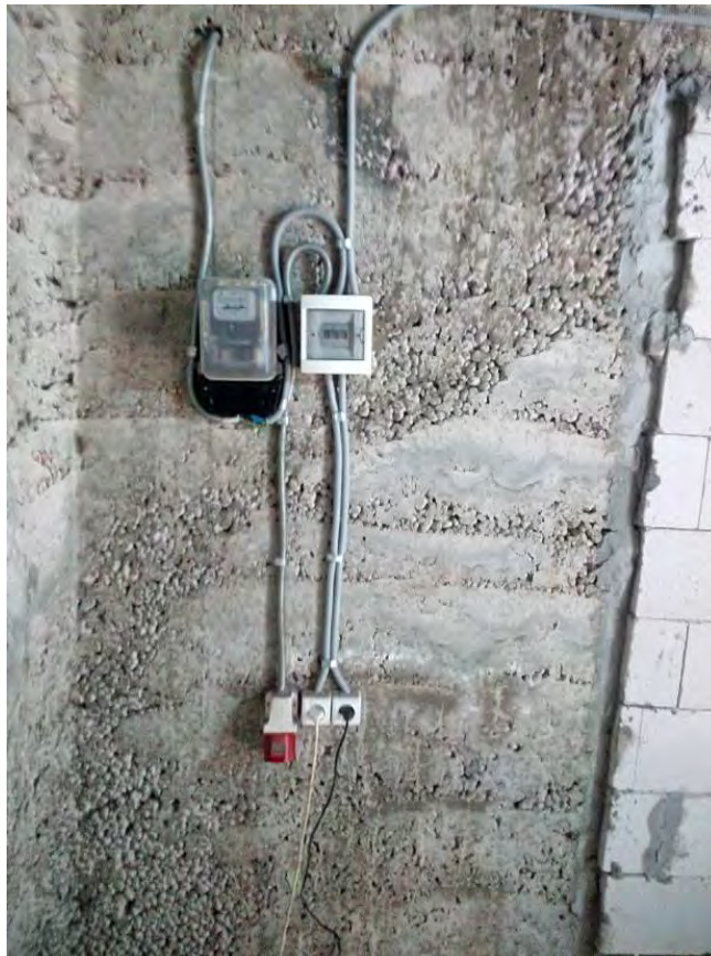
Рисунок 7 – Електричне живлення будинку з лічильником
