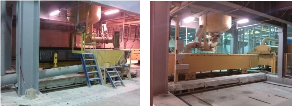
Рис. 5.5 – Распределительное устройство для заливки смеси в форму
