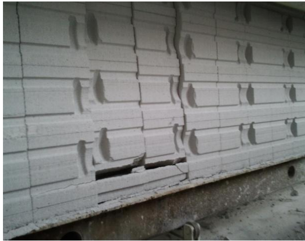
Рис. 5.40 – Механические повреждения массивов на делителе
