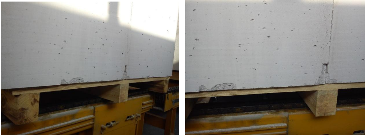
Рис. 5.44 – Околы бетона, полученные на уплотнителе
