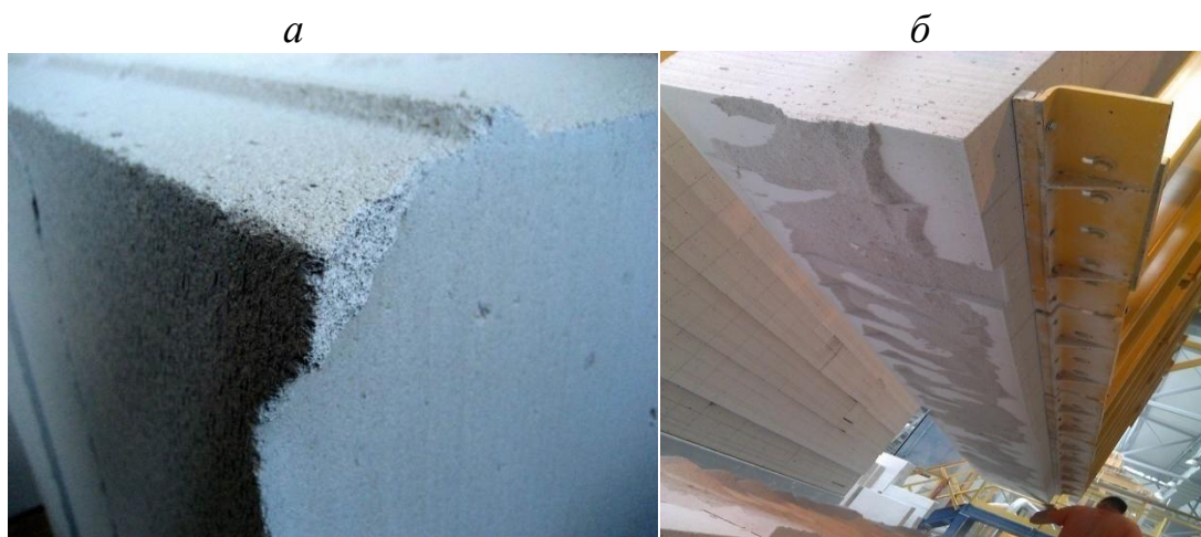
Рис. 4.5 – Дефекты изделий из ячеистых бетонов автоклавного твердения а – слипание вертикальных рядов блоков; б – не отделившийся подрезной слой в массиве
