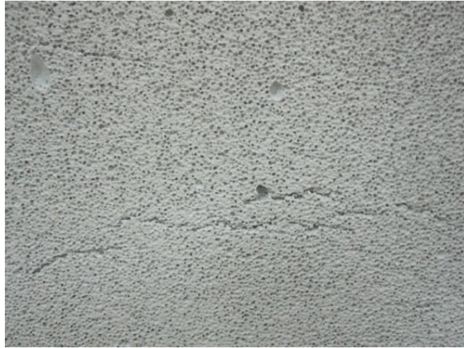
Рис. 5.32 – Усадочные трещины в теле ячеистого бетона
