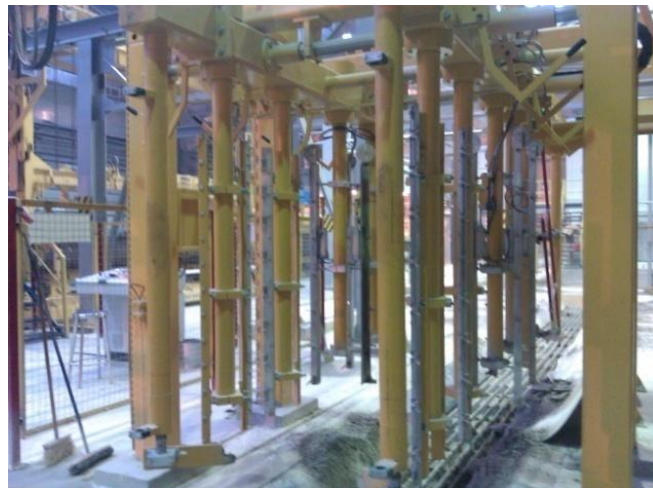
Рис. 5.11 – Установка боковой обрезки и профилировки массива
