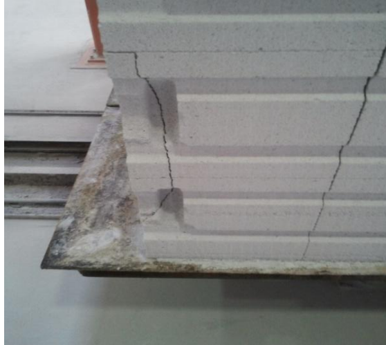
Рис. 5.37 – Механические повреждения массива при резке
