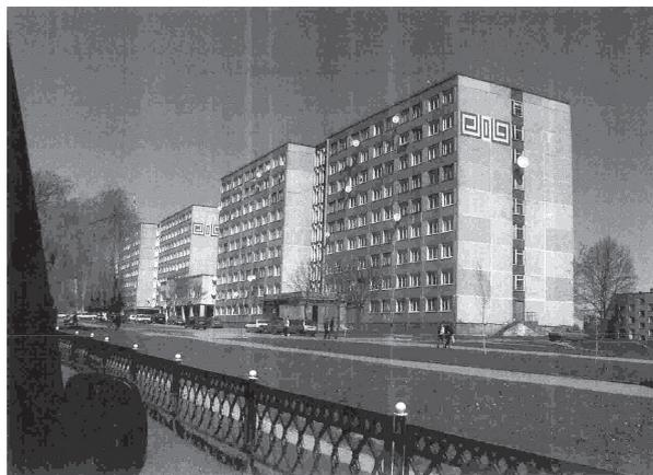
Рис. 2. Общежитие из силикатобетона на 745 мест
